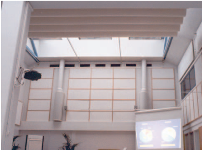
Sähkökäyttöinen laskostuva PV 500 -kattopimennysverho, koko 7 m x 7 m. M-real Oyj:n koulutuskeskus Silva, Tampere.
