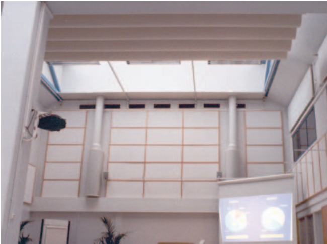
Sähkökäyttöinen laskostuva PV 500 -kattopimennysverho, koko 7 m x 7 m. M-real Oyj:n koulutuskeskus Silva, Tampere.
