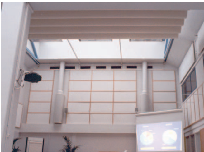
Motordriven veckad PV 500 takmörkläggning, storlek 7 m x 7 m. M-real Oyj's utbildningscentrum Silva, Tammerfors.
