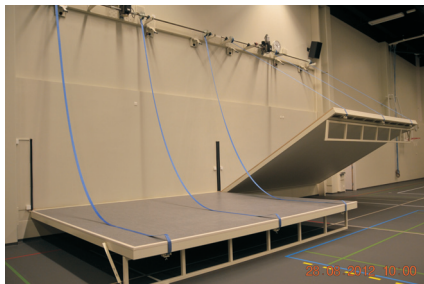
2-osainen näyttämö, koko 10500 x 4500 mm. Seinällä oleva koneisto voidaan suojata kotelolla, jolloin seinän ulkonäön esteettisyys säilyy. Niemenranta-talo, Oulu.
