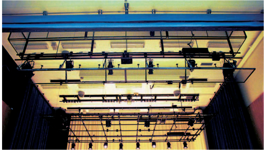
Sähköisesti nostettava ja laskettava putkiristikko lavasteiden, kulissiverhojen ja valaisimien kiinnitykseen. Kottby svenska lågstadium, Helsinki.
