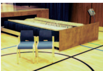
Näyttämön alla oleva tuolivaunu ulos vedettynä. Vaunussa säilytetään yleisötuoleja, tätä tuolimallia sopii jokaiseen vaunuun 100 kpl.
