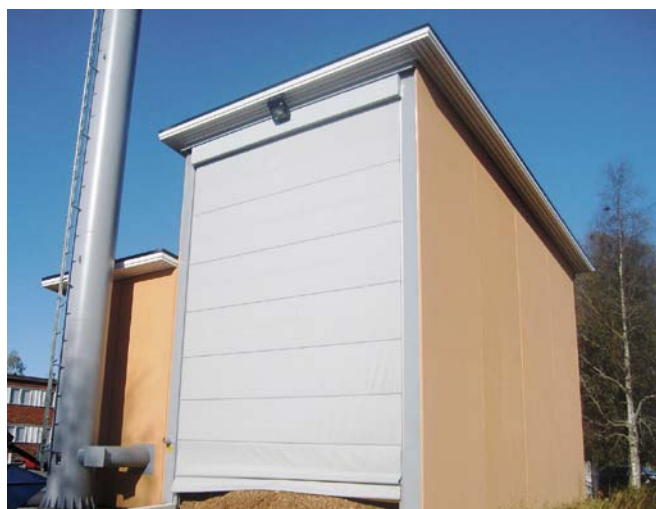
TNO-800 Outdoor/Insulated, 5500x9000 mm. Lämpökeskuksen polttoainevastaston nosto-ovi voidaan sulkea haluttuun asentoon polttoainemäärästä riippuen.
