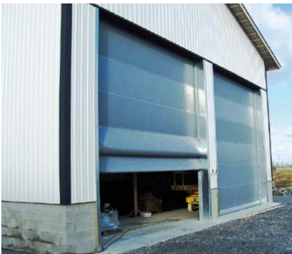
Nosto-ovi läpinäkyvällä kankaalla keventää tuulikuormaa ja päästää valoa sisälle. Vahvat alumiiniprofiilit antavat tukevuutta nosto-ovelle.
