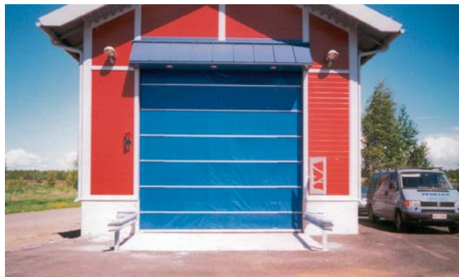
TNO-800, 4500x4800 mm. Taskilan jätevedenpuhdistamo. Nosto-ovi kaksinkertaisella kankaalla, osittain eristetty.
