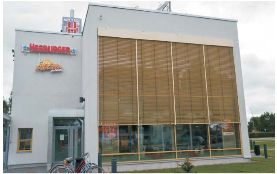
WAREMA-julkisivusälekahtimien E 80 A6 RE. Kaukosäädettävä EFWS-kello-ohjaus laskee ja nostaa kaihtimia liikkeen aukioloaikojen mukaan. Hesburger, Pori.
